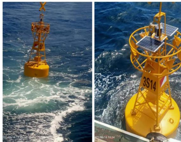
施工海域浮标及警示灯
